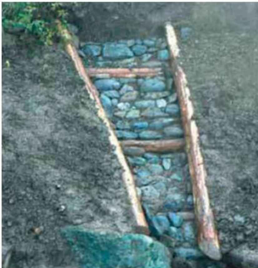
Bajante en piedra y madera con cajero simple
