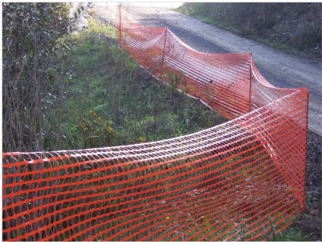
Ilustración 1. Balizamiento simple de protección.
