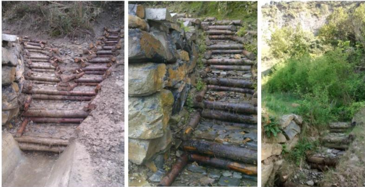
Bajante en piedra y madera. Adaptación de la cuneta con saltos y su evolución en el tiempo
